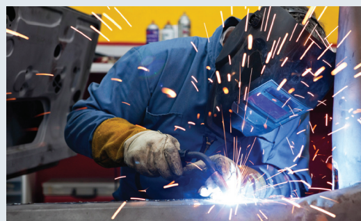
Revestimientos continuos con soldaduras de Heliarc para control de fugas
